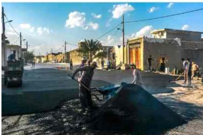
کمک در اجرای قرار داد آسفالت محله گلشن
